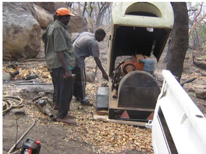
Il compressore stradale per l'apertura delle piste al lavoro
